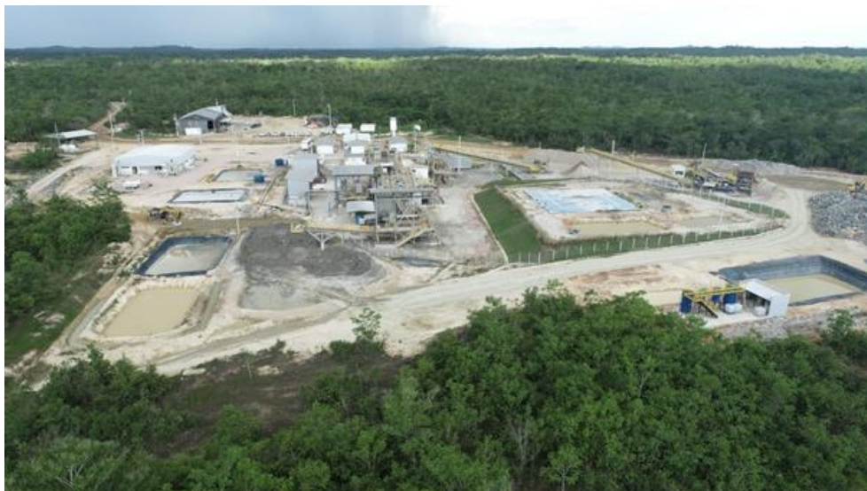
Figura 2.10 - Vista aérea mostrando a área da Planta Hidrometalúrgica e Apoio Administrativo atuais
