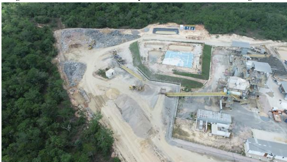
Figura 2.9 - Vista aérea mostrando parte da Planta Hidrometalúrgica atual
