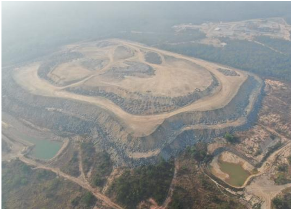
Figura 2.7 - Vista aérea mostrando a Pilha de Estéril/Rejeitos em operação
