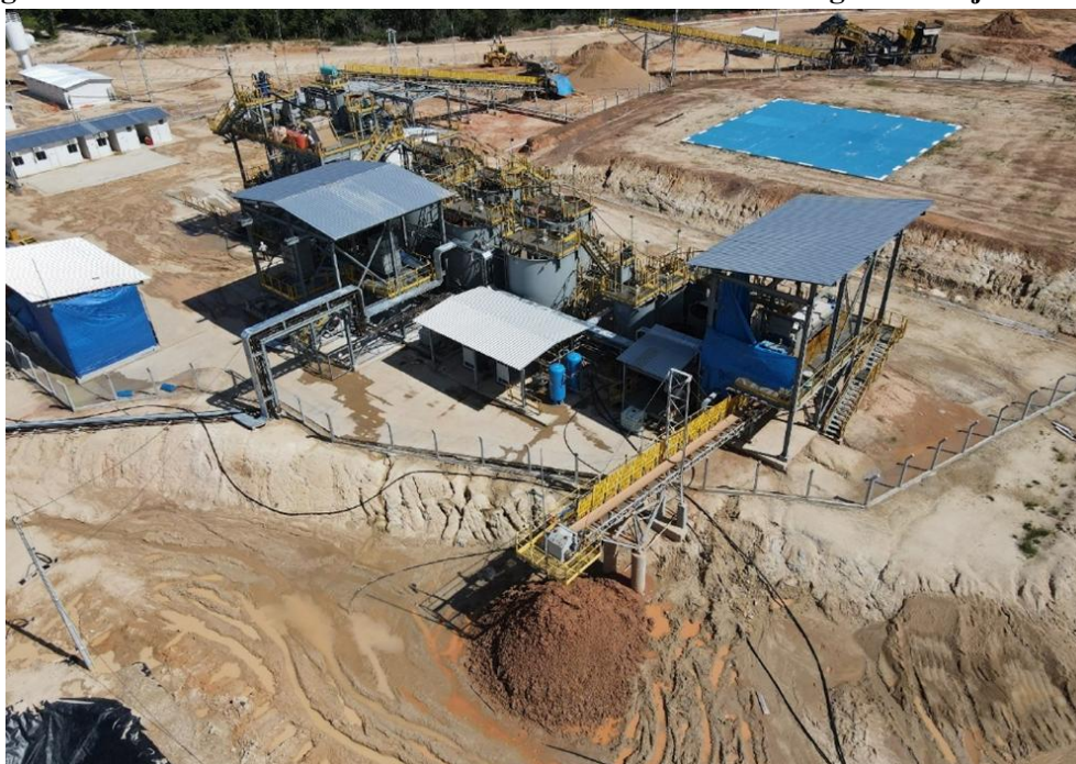
Figura 2.11 - Vista aérea mostrando a área da Planta de Filtragem de Rejeitos atual
