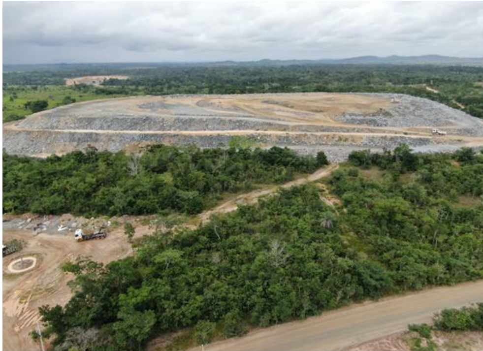
Figura 2.8 - Vista aérea mostrando a Pilha de Estéril/Rejeitos em operação
